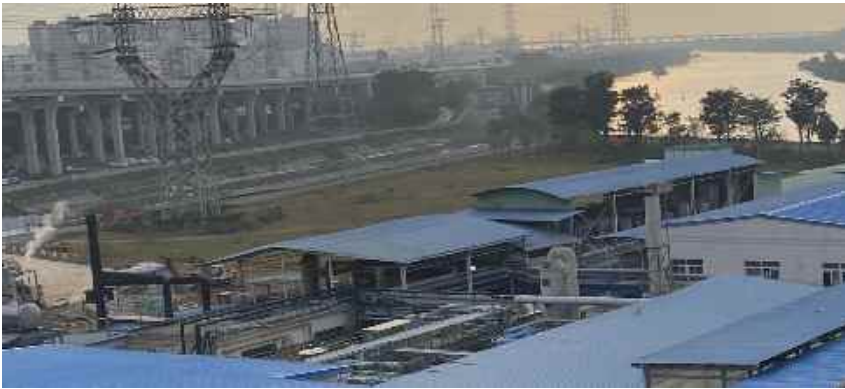
项目南侧工业厂房
