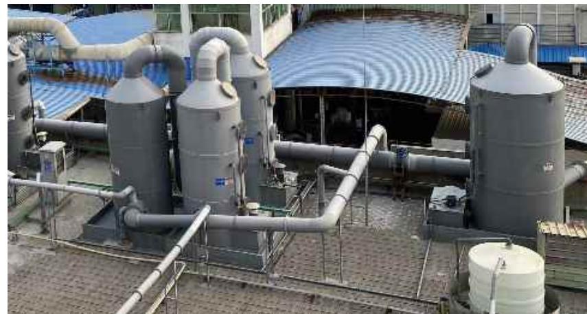
项目北侧工业厂房
