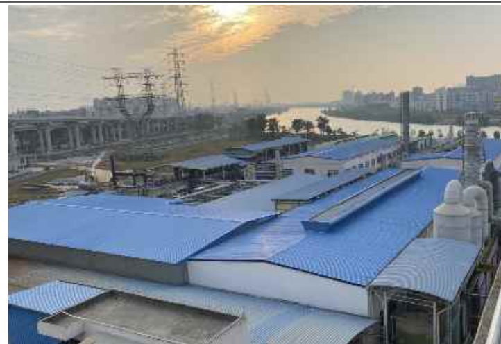
项目西侧工业厂房
